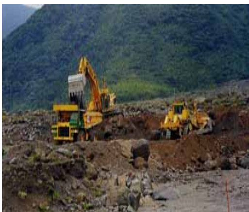
砂防ソイルセメント材料の 現地発生土砂の採取
