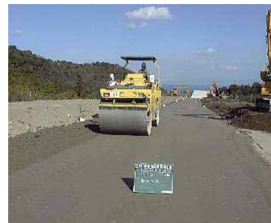
砂防ソイルセメント締め固め（振動ローラ）
