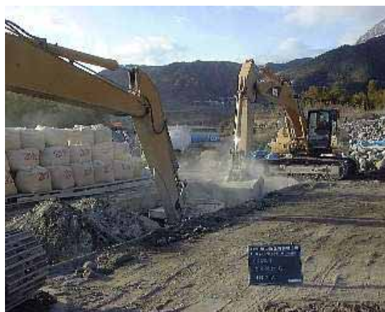
砂防ソイルセメント材料の混合
