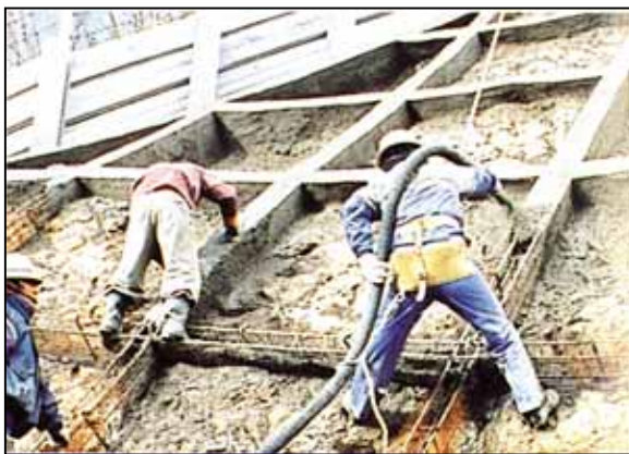
従来工法 (現場吹付法砕工)
