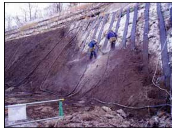
採用工法 (連続繊維補強土工)
