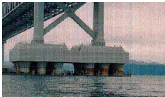
大鳴門橋多柱基礎
