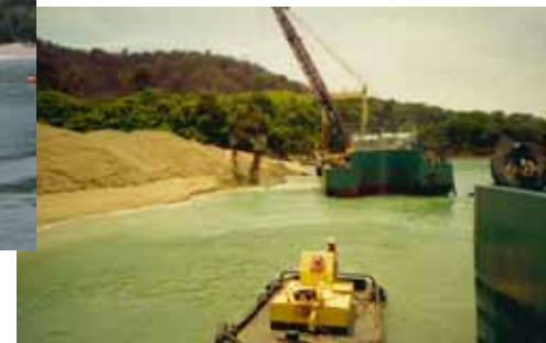
（屋釜海岸養浜後(竣工時)：上 屋釜海岸養浜施工状況：右)
