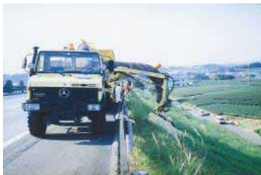
(本線盛土のり肩草刈)
