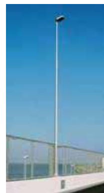
新型照明柱と高圧ナトリウム灯
