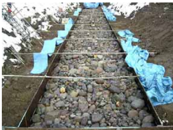
(粗石投入状況)
