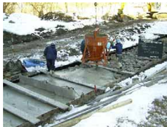
(コンクリート打設状況)
