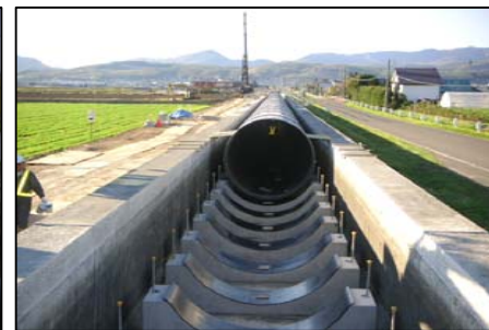
旧開水路内にパイプを布設
