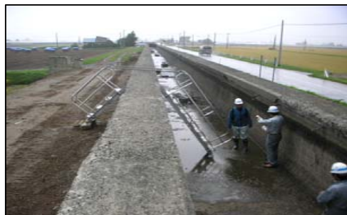
撤去予定だった開水路
