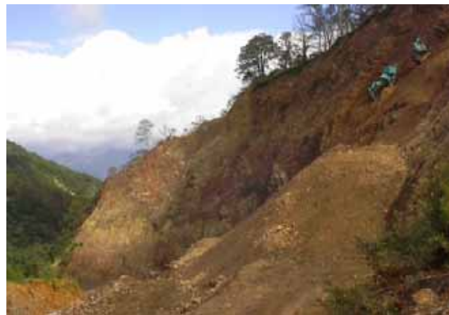
(無人機械による掘削状況)
