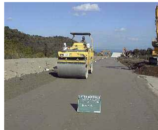
CSG締固め状況
