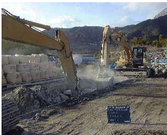
CSG攪拌状況
