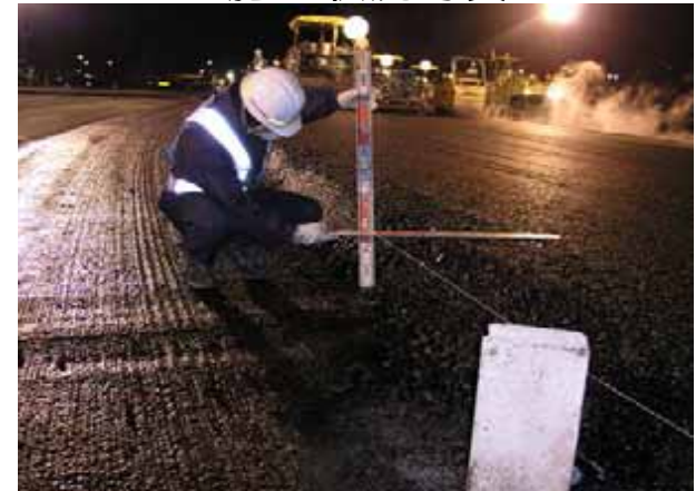
施工状況写真
