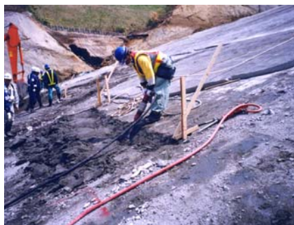
ピックハンマ人力掘削 従来工法
