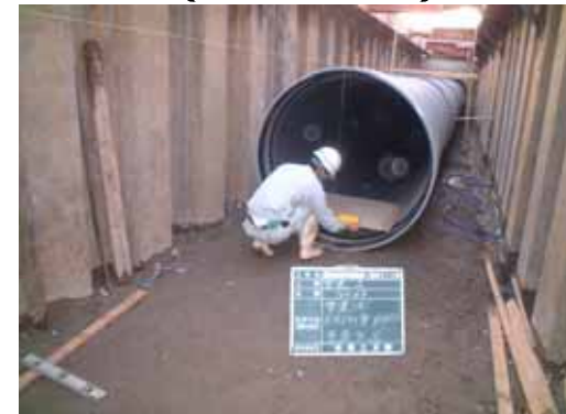
新工法（FRPM管）
