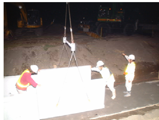
プレキャスト製品の据付
