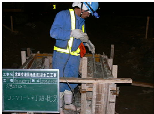
従来の工法によるコンクリート打設
