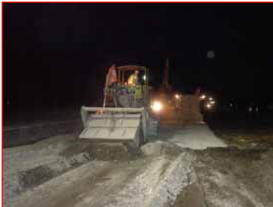
路床改良状況
