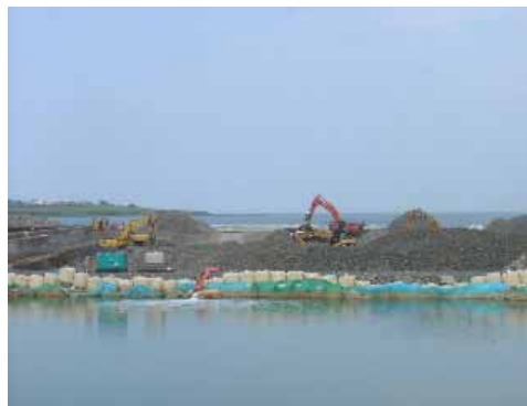
陸上機械による掘削
