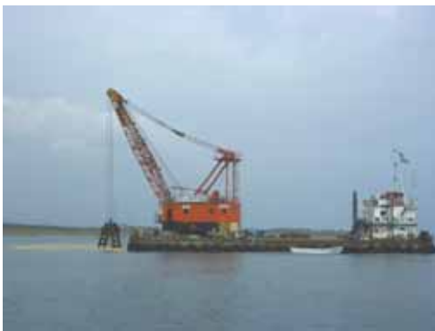
浚渫船による海上工事
