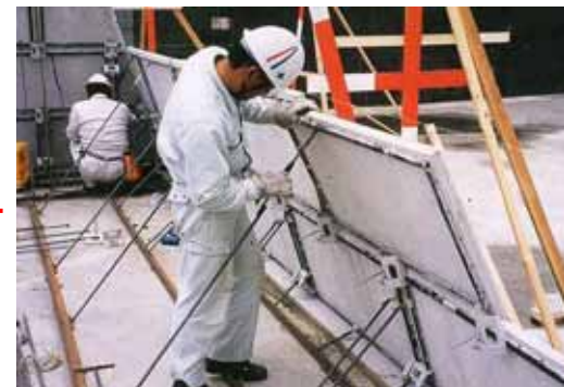
残存型枠施工状況写真
