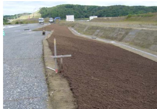
吹き付け完了
