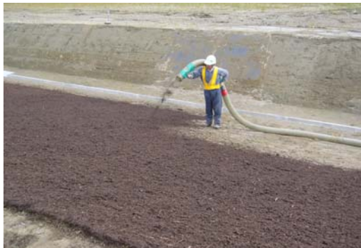
吹き付け状況
