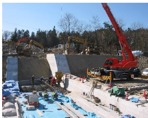
(コンクリート打設・養生)
