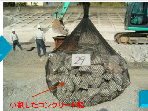
護岸取壊し(コンクリート殻の発生) 袋詰玉石工の製作
