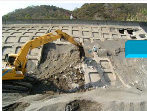
護岸取壊し(コンクリート殻の発生) 袋詰玉石工の製作
