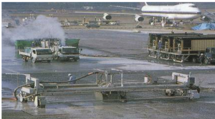
オーバーレイ工法の工事写真
