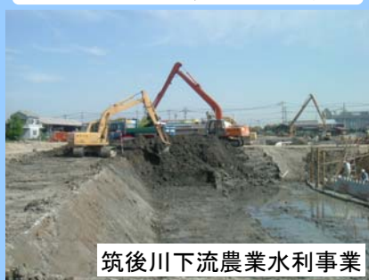
建設発生土（農水省現場）
