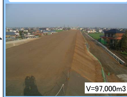
有明海沿岸道路 盛土施工
