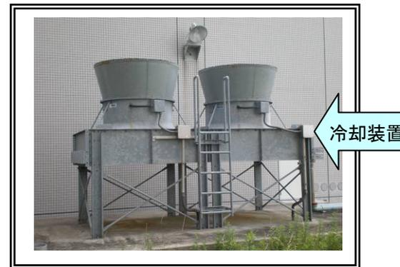
ラジエター式冷却方式
