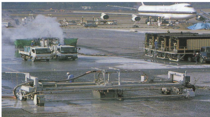
オーバーレイ工法の工事写真
