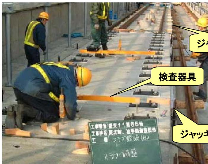
検査器具で、高低変位のチェックを行い、ジャッキで調整
