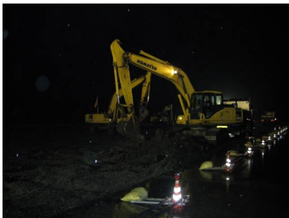
路盤撤去状況
