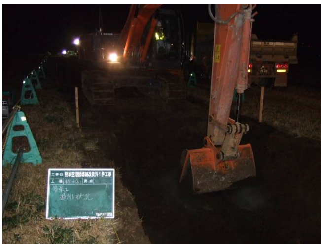
施工箇所、積込状況
