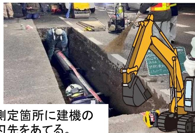
刃先の3次元座標データを用いて計測
