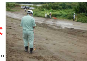
設計面と施工後の仕上がり面の高さの差を3次元的に確認
