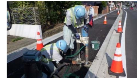
舗装版削孔工
