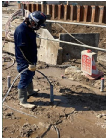
二重管ダブルパッカー工法 注入作業状況
