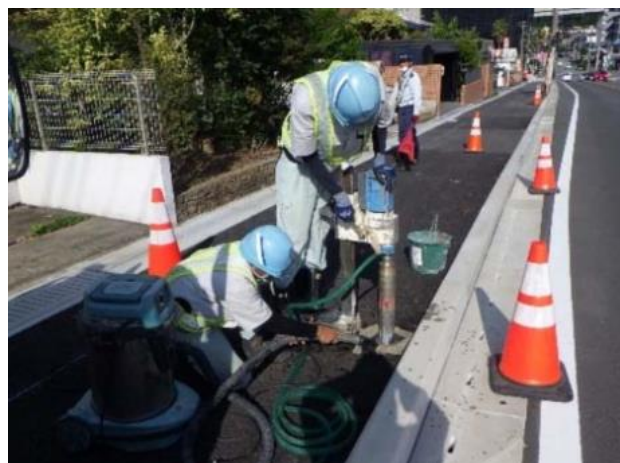
削孔作業状況
