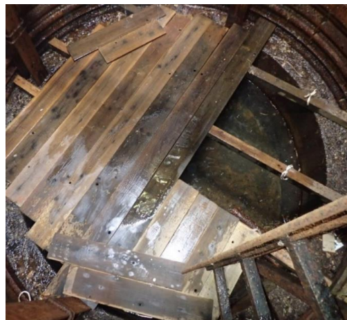
足場設置・撤去作業状況
