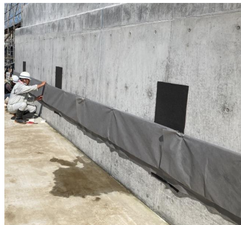
排水材設置作業状況 (接着剤)
