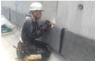
排水材設置工
