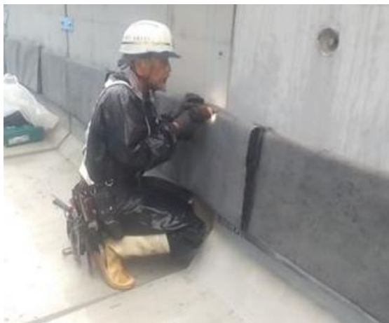
排水材設置作業状況 (コンクリート釘)
