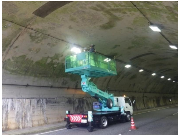
人力施工状況高所作業車(トラック架装)伸縮ブーム・プラットフォーム型
