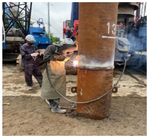
継手溶接作業状況
