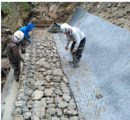
かが組立・据付け作業状況
