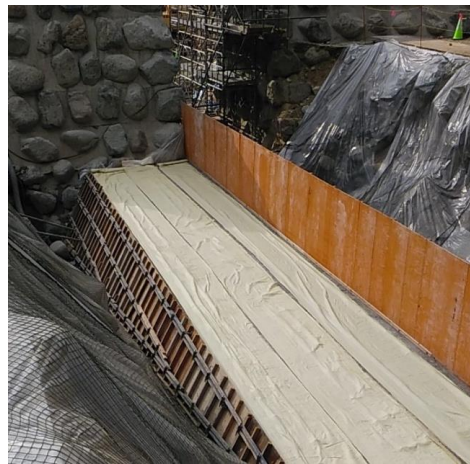
コンクリート養生作業状況
