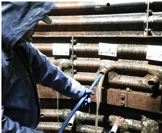
孔内洗浄作業状況(井内作業)
