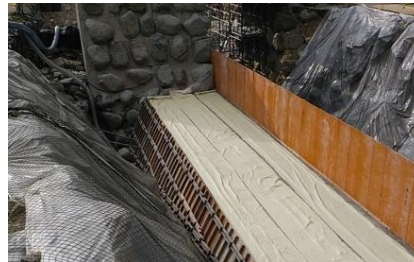
仮締切工 (砂防コンクリート締切)
