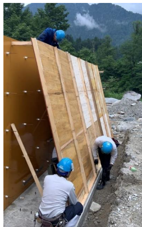
型枠組立作業状況
