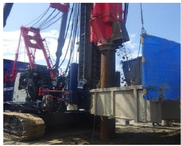
杭打作業状況
