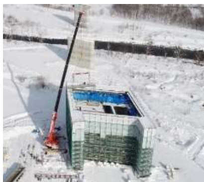
プレキャスト部材の活用
