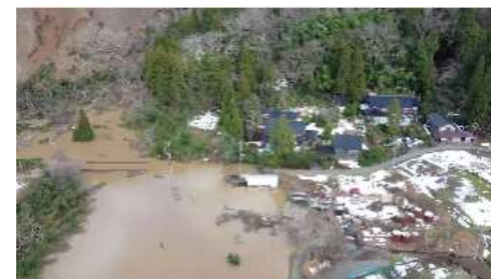
能登半島地震 (R6.1, 1) (石川県輪島市) TEC-FORCE撮影
