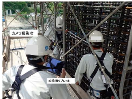
①臨場(受注者)の状況
