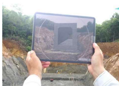
AR（拡張現実）による施工イメージの共有
