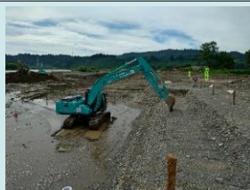
遠隔施工状況
