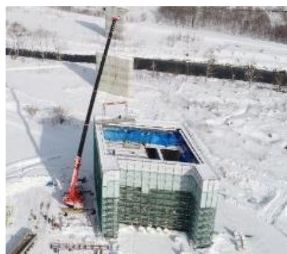
プレキャスト部材の活用
