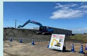
遠隔施工状況
