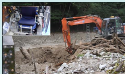
無人バックホウ稼働状況
