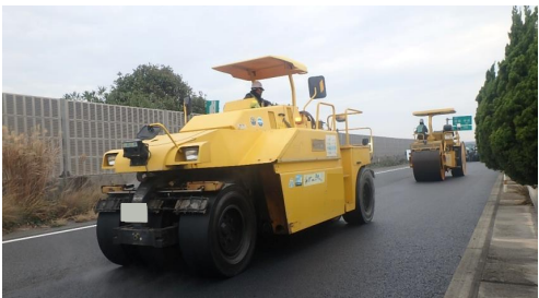
ロードローラ・タイヤローラによる締固め
