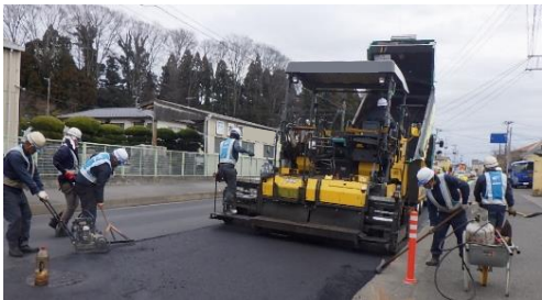
アスファルトフィニッシャによる敷均し
