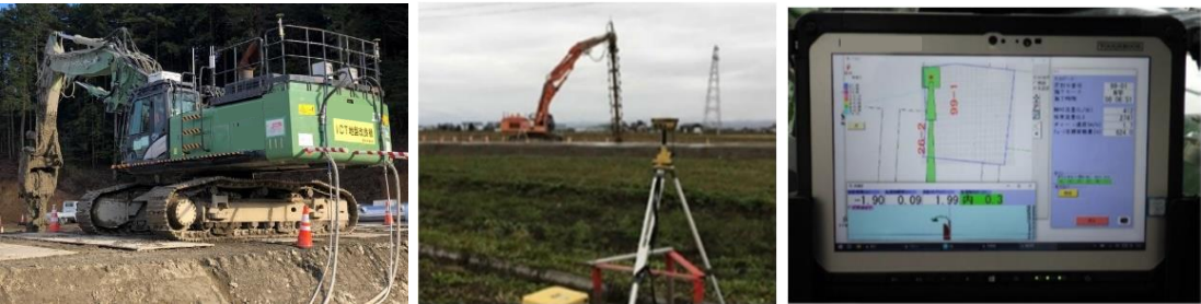
ICT中層混合処理機工による攪拌混合
