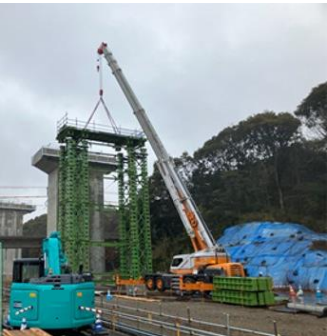
バント設備設置
