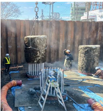
杭頭処理状況
