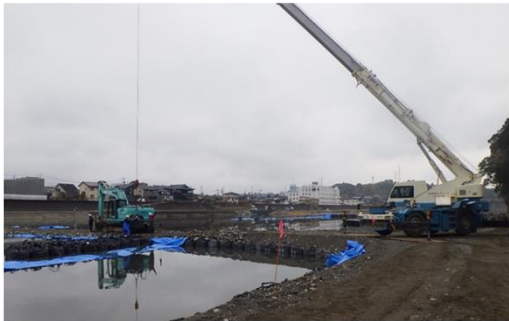
クレーンによる移設作業
