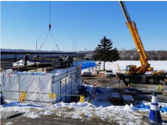
設置状況（Wタイプ）
