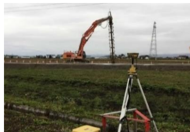
中層混合処理工（ICT）
