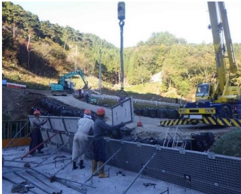
型枠組立・設置
