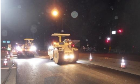
ロードローラ・タイヤローラによる締固め
