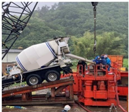
コンクリート打設状況
