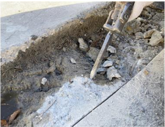
コンクリートはつり 施工状況
