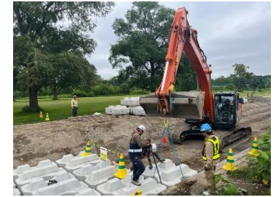
消波根固めブロック工
