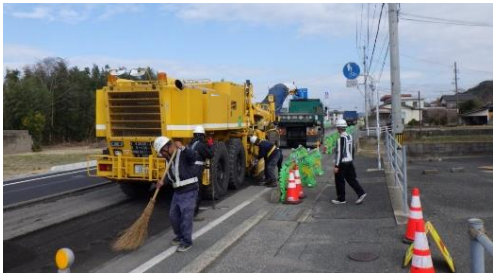
路面切削機による切削
