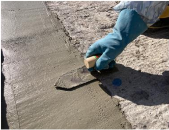
断面修復 (左官) 施工状況
