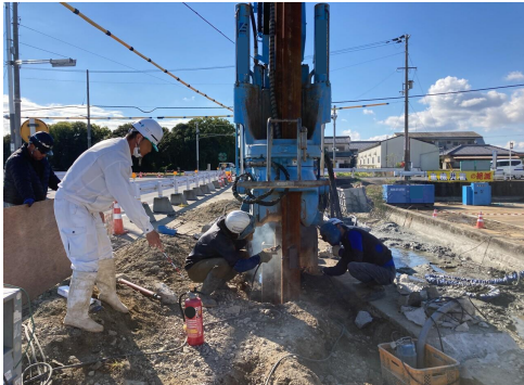
継施工溶接状況
