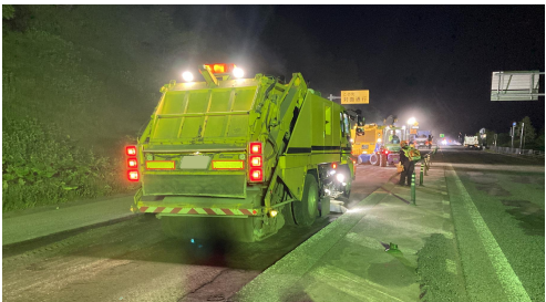
路面清掃車による清掃
