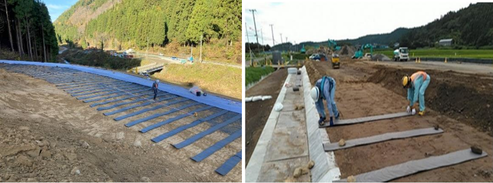
水平排水材シート設置状況
