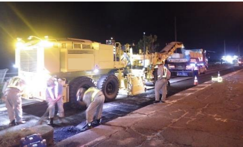
路面切削機（ICT）による切削
