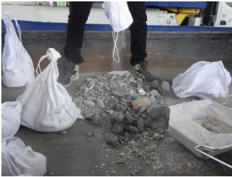
コンクリート殻 積込 施工状況
