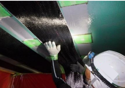
炭素繊維シート貼付
