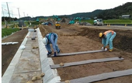
排水材設置工
