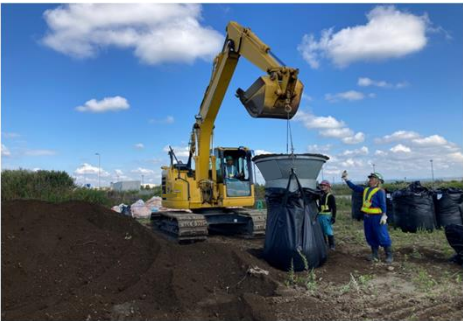
大型土のう製作
