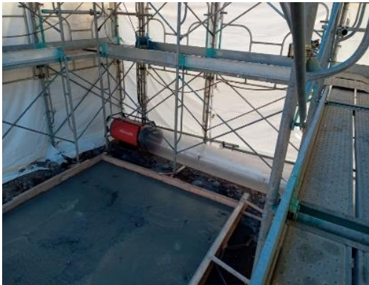
養生工（囲い内の状況）
