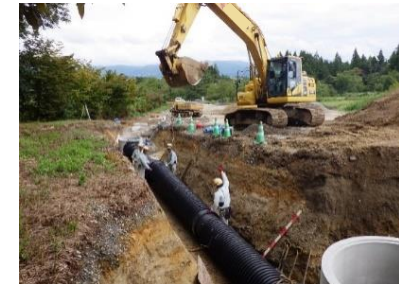
排水構造物工（暗渠排水管）
