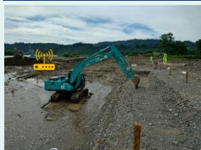
遠隔施工状況
