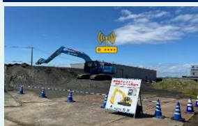
遠隔施工状況
