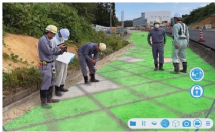
ARを活用した土工の出来形確認
