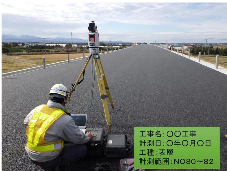
図-4 写真撮影例（TLSの場合）
