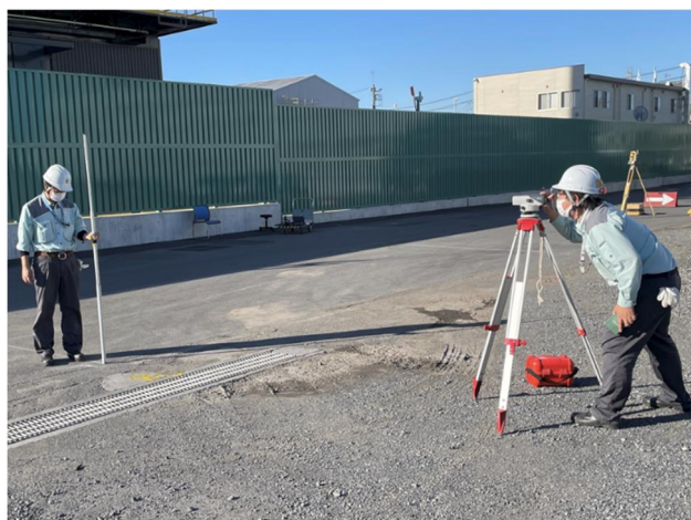
図ー 5 出来形計測状況
