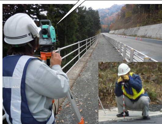
図ー 4 出来形計測状況
