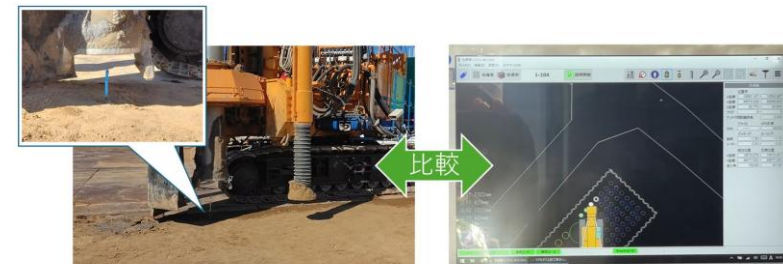
・下げ振り等で先端の位置をマーキング ・マーキング位置のx,yをTSで計測
