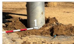
③ケーシング先端を一定量下げる （この例では1m下げ）
