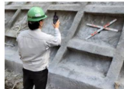
標尺設置状況
