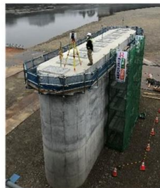
橋脚上部の計測
