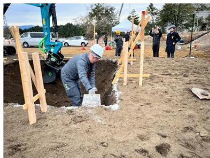
手元作業員が多い現場
