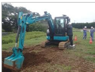
建設機械施工実習
