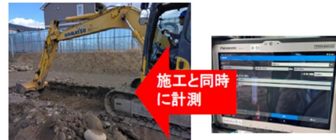
②3D-MG施工 + ②刃先による計測
