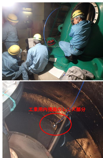
図 4.1-1 工業用内視鏡による主ポンプ診断
