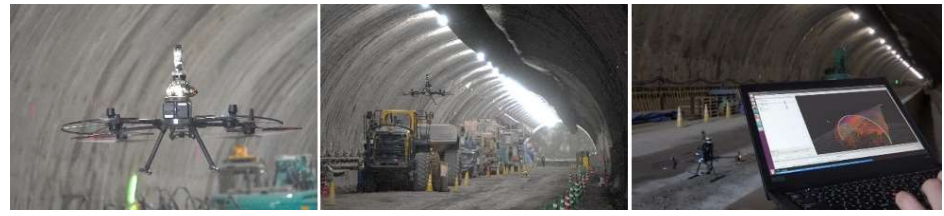
トンネル坑内のドローン自律飛行の様子
