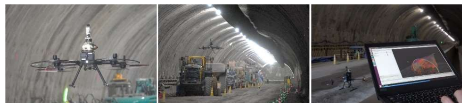
トンネル坑内のドローン自律飛行の様子
