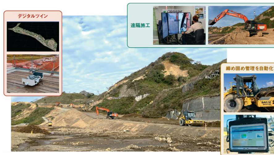
遠隔施工の現場状況
