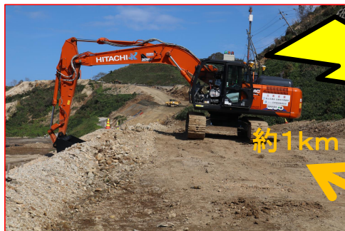
【遠隔操作される重機】
