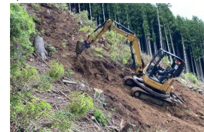
危険箇所 (崩壊斜面) での無人化施工 (奈良県)
