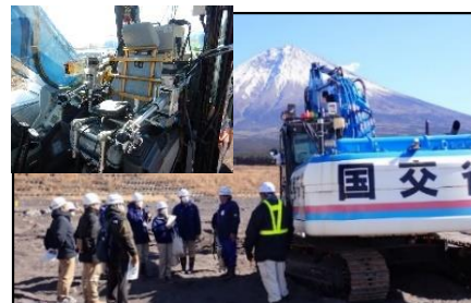
国土交通省保有の遠隔施工機械を活用した操作訓練
