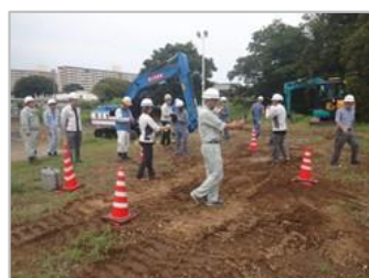
出来形計測実習
