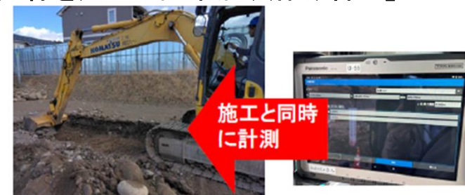
②3D-MG施工 + ②刃先による計測
