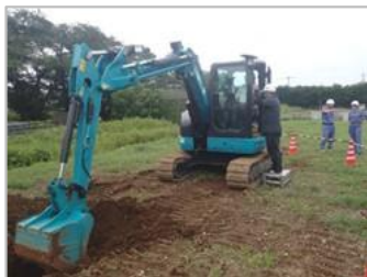
建設機械施工実習
