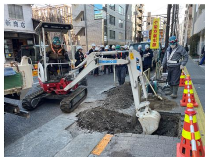
GX建機の実現場での活用事例
