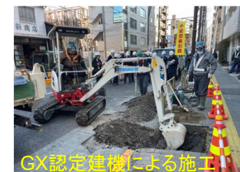
GX建設機械認定型式を使用した直轄工事における施工事例
