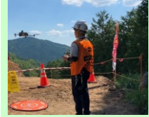
作業員による3次元測量
