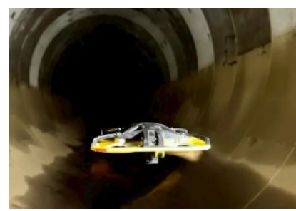
ドローンによる目視調査 (全国特別重点調査)
