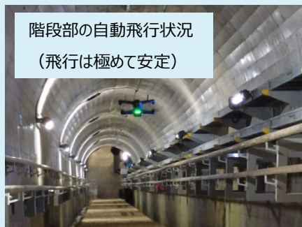
仮設の監査廊照明 (LED増灯)
