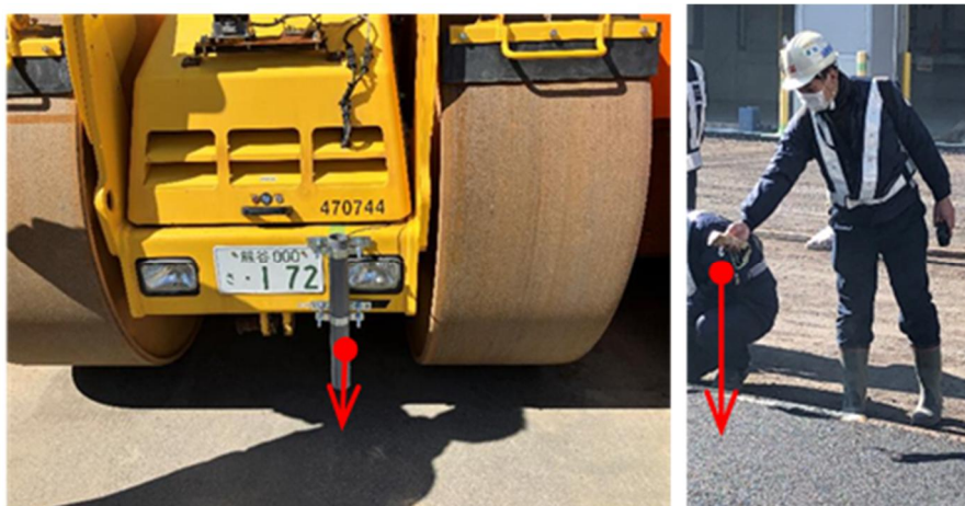
写真 3-1 計測温度の精度確認（例）
