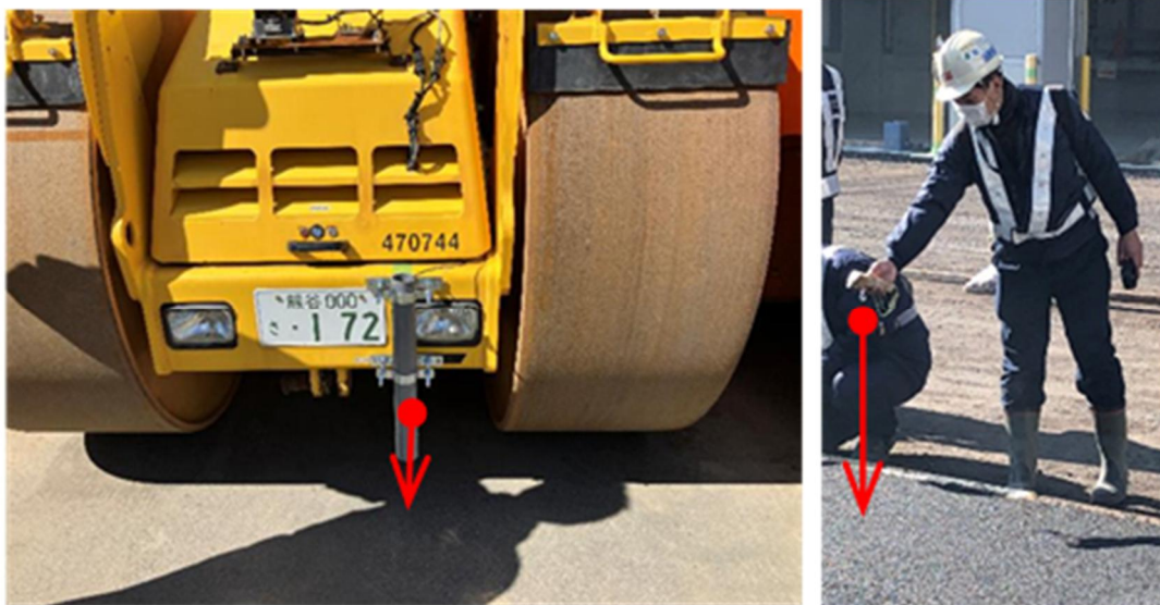
写真 2.1 計測温度の精度確認（例）
