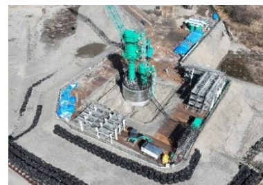
ニューマチックケーソン工
