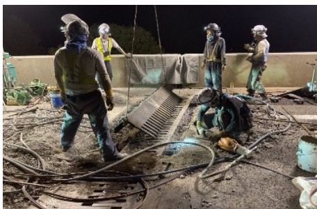
既設ジョイント撤去状況
