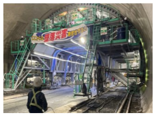
スライドセントル移動・据付
