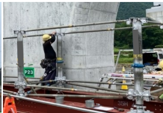
大型パイプ支柱設置状況
