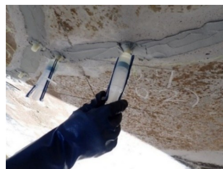
注入器具取付
