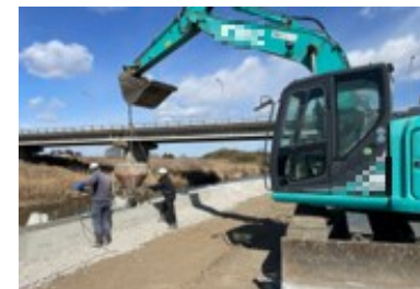
笠コンクリートブロック据付工
