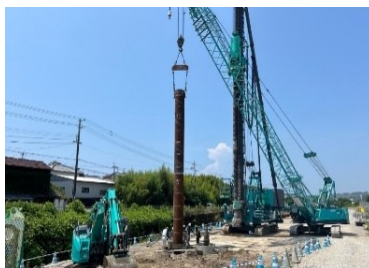
鋼管ソイルセメント杭工
