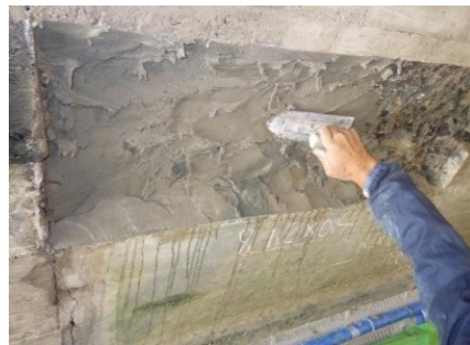
断面修復 (左官) 施工状況
