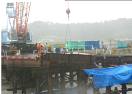
上部工（H形鋼主桁）架設状況
