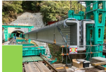
架設桁架設状況
