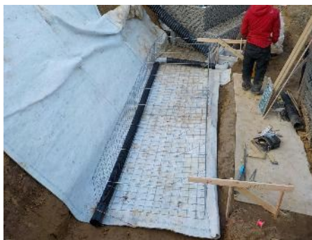
吸出し防止材設置
