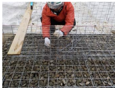
かご組立・据付け
