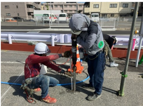
丸パイプ土中打込作業状況
