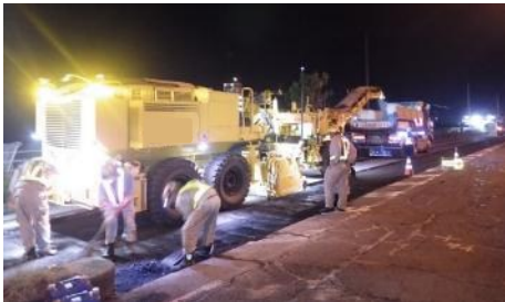
路面切削機 (ICT)による切削
