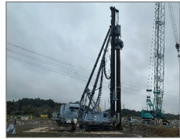
固化体一般部造成・鋼管沈設（同時沈設方式）
