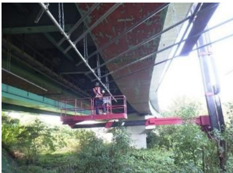
パイプ吊足場設置状況
