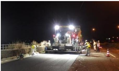
アスファルトフィニッシャによる敷均し
