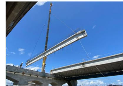
P C橋架設工
