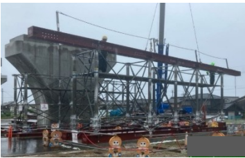
受桁設置状況
