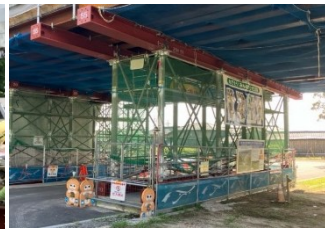
支柱支保設置状況
