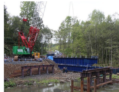
上部工（仮設鋸桁）架設状況
