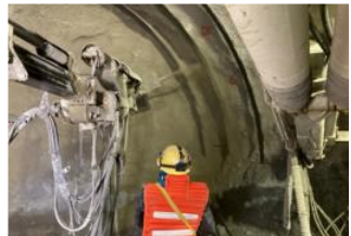
コンクリート吹付
