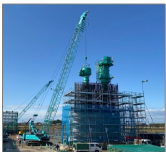
艀装設備組立
