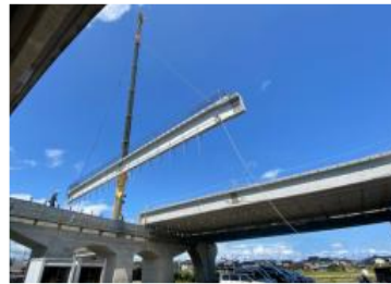
クレーン架設
