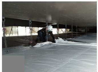
橋梁補修工 (塗装塗替足場工)
