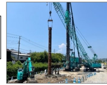
鋼管の吊込み・沈設（後沈設方式）
