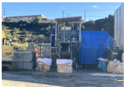
発生土積込状況
