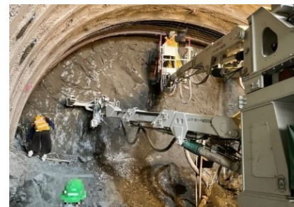
トンネル工 (NATM) [発破工法]
