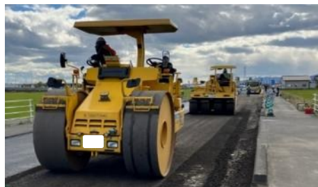
ロードローラ・タイヤローラによる締め固め
