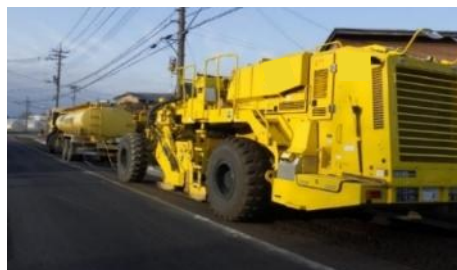
スタビライザによる破碎混合・乳剤散布
