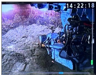
沈下掘削 (無人掘削)
