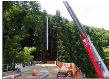
鋼管建込状況
