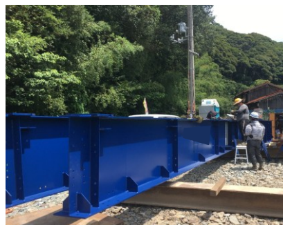
上部工（仮設鋸桁）地組状況
