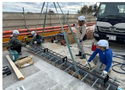
ジョイント設置状況
