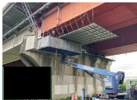
システム（パネル式）吊足場設置状況
