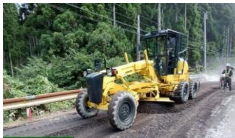
モータグレーダによる不陸修正
