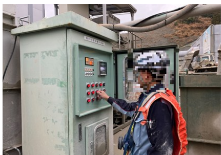
保守点検状況
