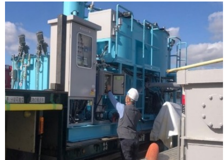
保守点検状況
