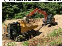
自動施工の高度化
