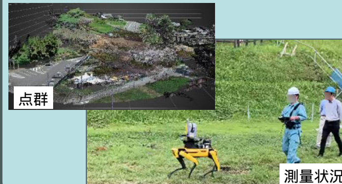
西那須野道路の工事測量で活用
