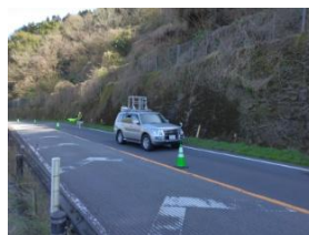
MMS 1 を活用した 斜面・のり面点検
