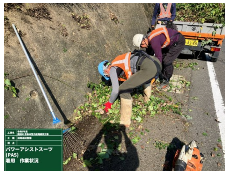
人力集草・積込 道路（かがみ）
