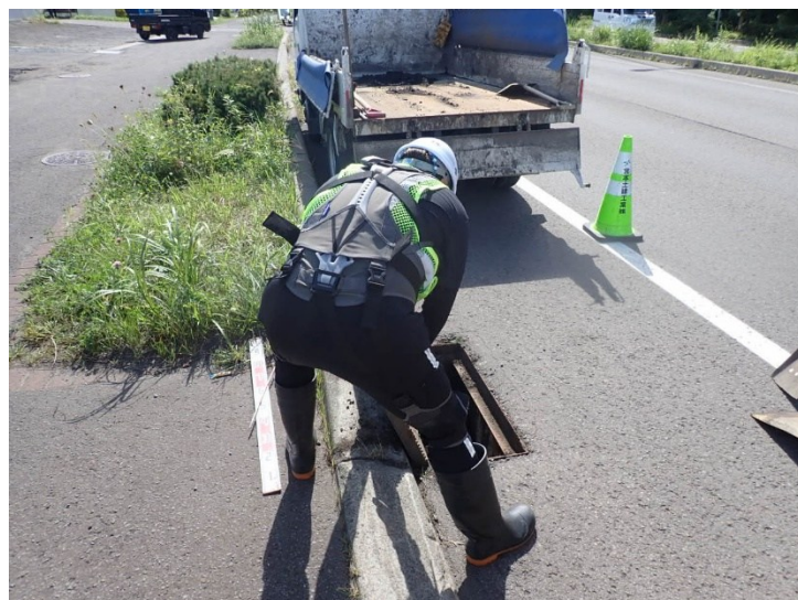
側溝清掃（かがみ）
