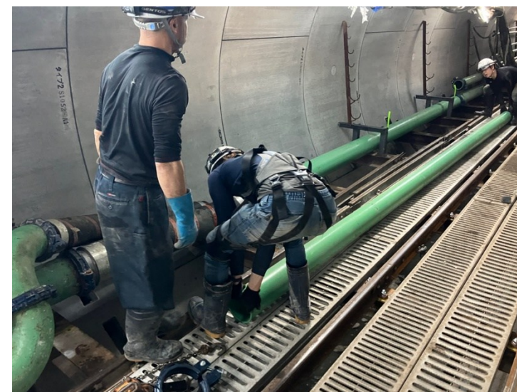
配管移動作業（かがみ）
